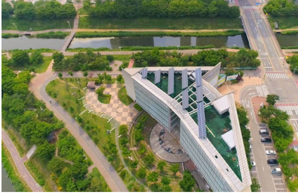
안산 중앙도서관 옥상에 설치된 태양광 발전기
