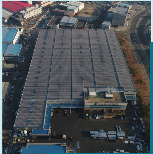
대구에 위치한 신성1호 발전소 전경
